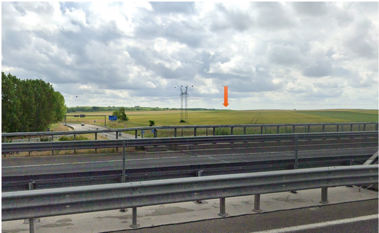
A 0541/163 hrsz-en üzemelő 1 MW-os naperőműpark látványa GOOGLE utcakép kivágaton, az M6-os autópálya Dunaföldvár / Solt / Előszállás csomópontjánál, a Pécs felé vezető oldalról nézve (a sárga nyíl mutatja a tervezési terület elhelyezkedését).
