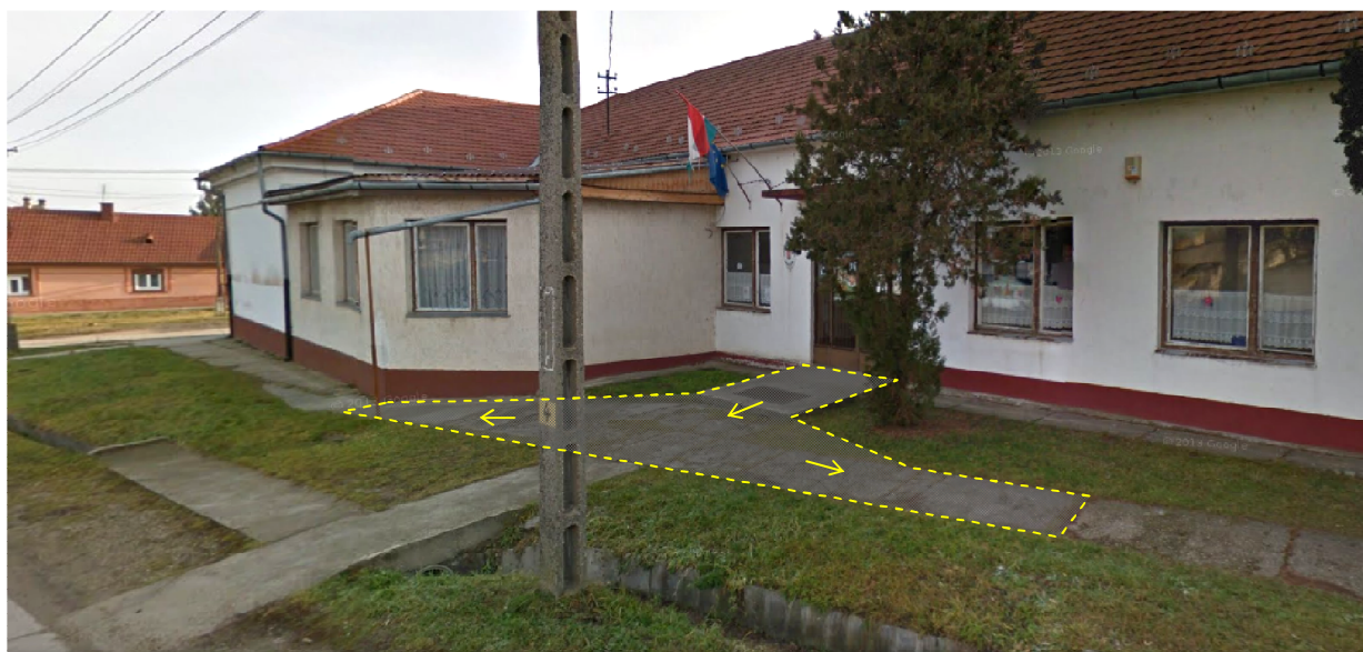
az újraépítendő járdaszakasz a kialakítandó lejtések jelölésével
