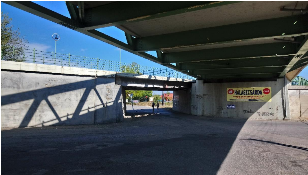
28. kép: A Duna utca hídfő alatti szakaszánál fontos, hogy az útirányjelző táblák, és a burkolati jelek megfelelően irányítsák a kerékpáros közlekedőket
