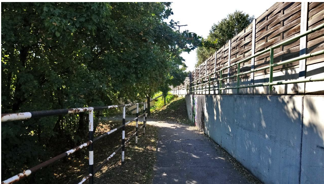
2. kép: Veszélyes, kis sugarú ív a híd töltéséről leérve
