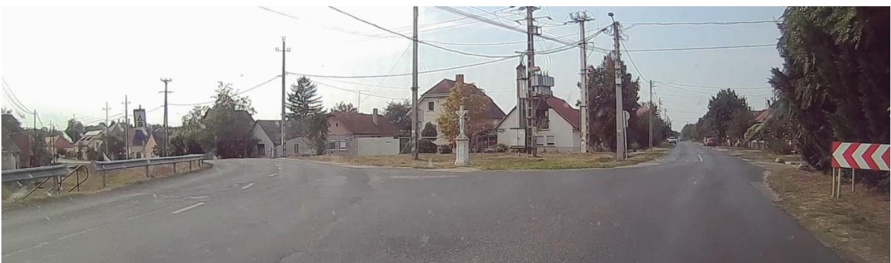
15. kép: Az Előszállási út – Pentelei út csomópontja nagy kiterjedésű, és nem elég hangsúlyosak az elsőbbségi viszonyok
