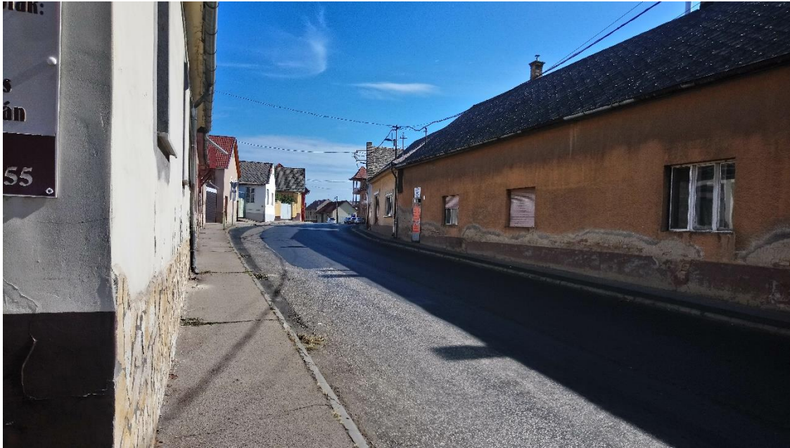
29. kép: Az utca Béke tér felőli szakasza keresztmetszetileg beszűkül, a gyalogos járda is éppen csak, hogy elfér.
