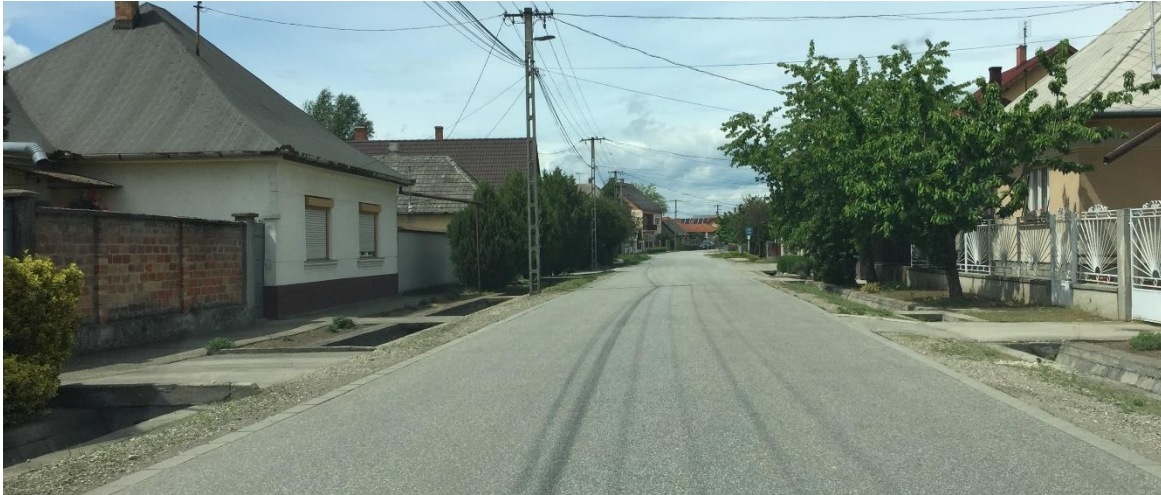
14. kép: Nyílt, burkolt árkok a Kereszt utca mentén. Nagy forgalom esetén balesetveszélyes, főleg a kerékpáros közlekedők számára
